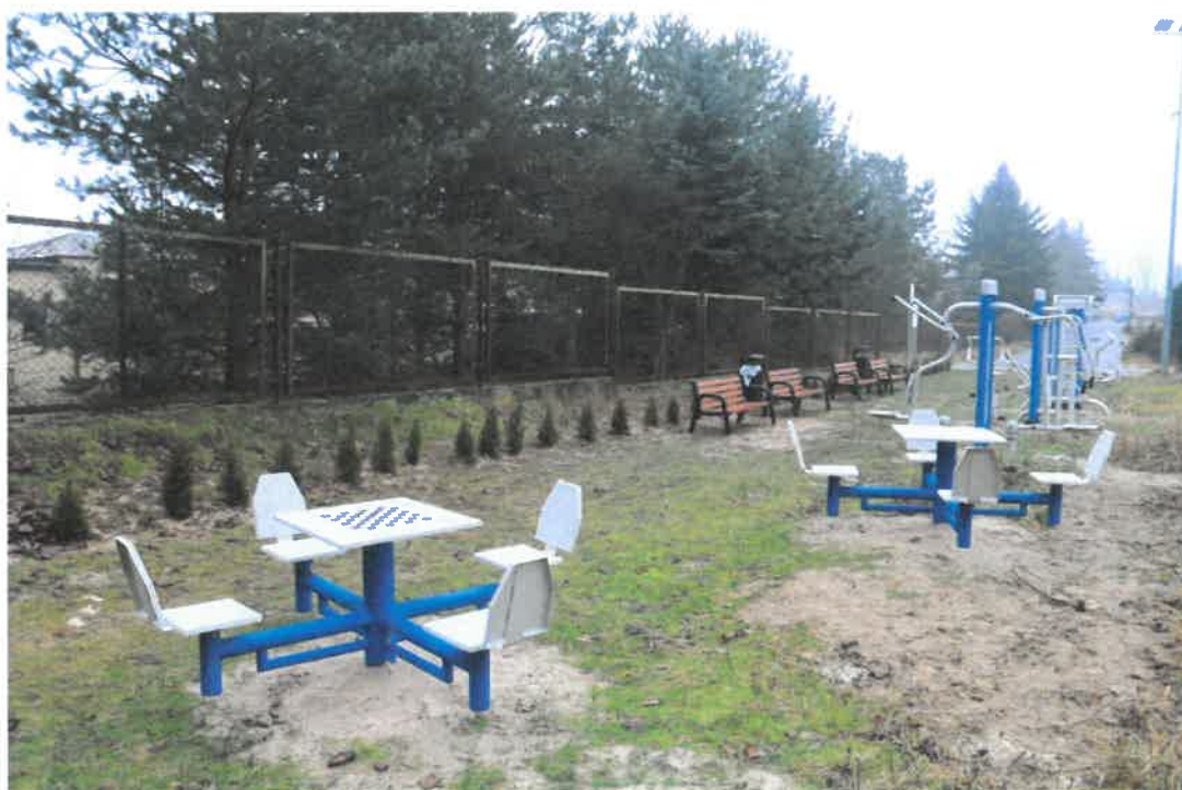
Budowa Otwartej Strefy Aktywności w Wysokiej
