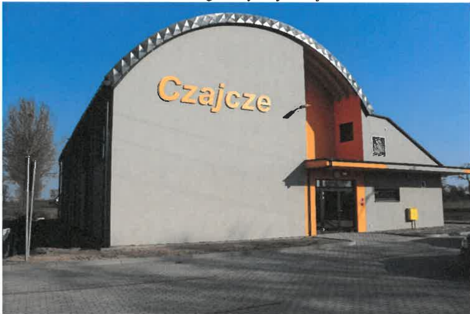
Budowa sali gimnastycznej w Czajczu
