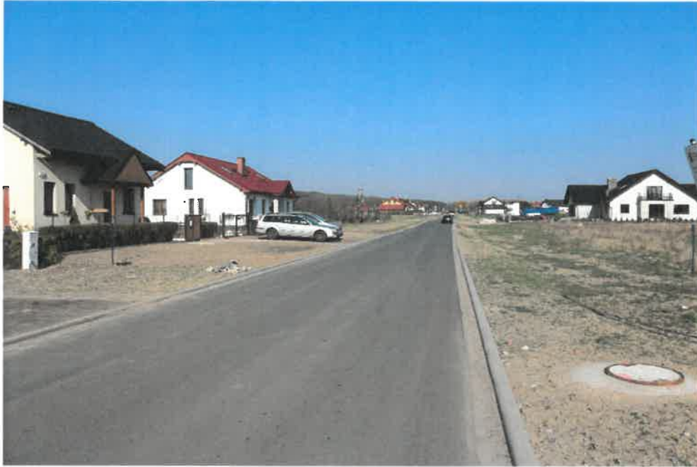
Budowa ul. Akacjowej
