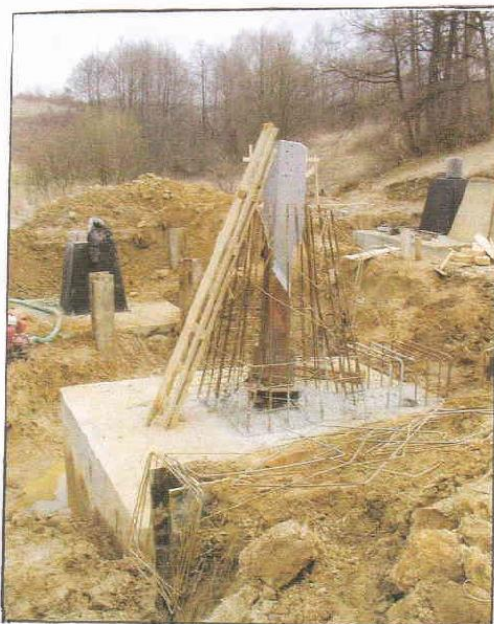
Budowa fundamentów terenowych pod stanowisko słupa
