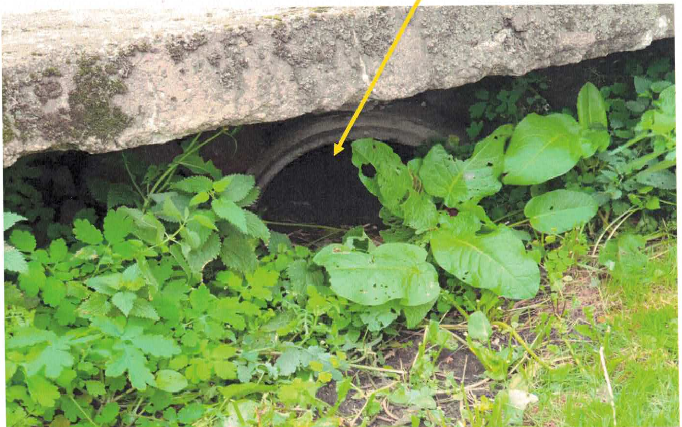
Zdjęcie nr 1 i nr 2 - Widok „niedroźnego” przepustu pod drogą Rudna – Mościska (za zakrętem – wyjazd z m. Rudna.)
