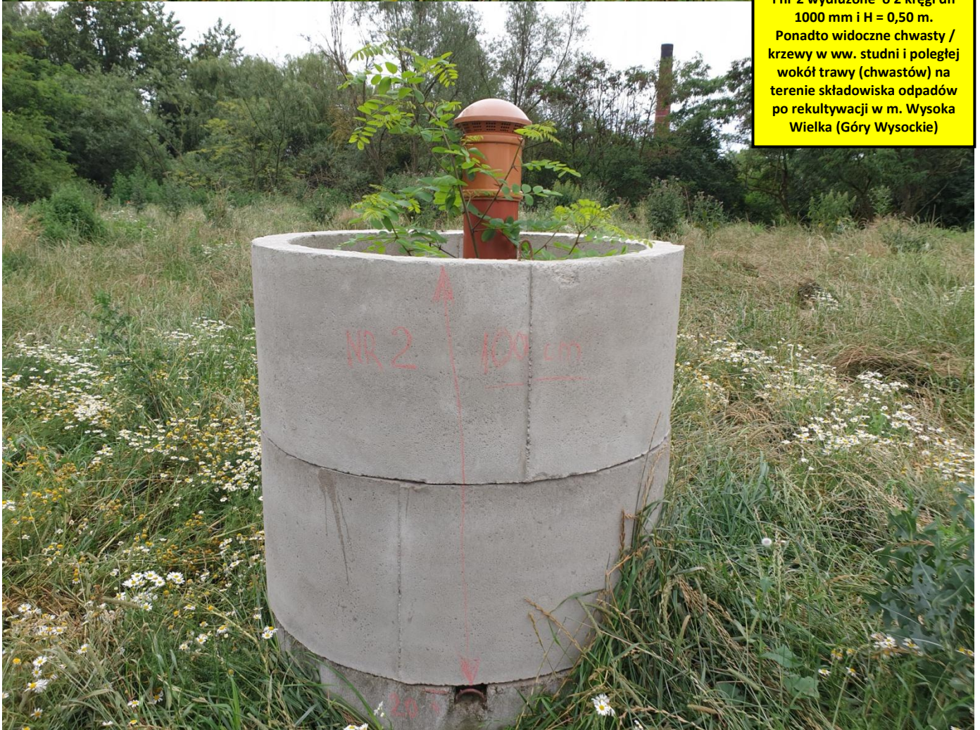
Zdjęcia nr 1 i nr 2 z dnia 08.07.2021r. - Widok studni odgazowujących nr 1 i nr 2
